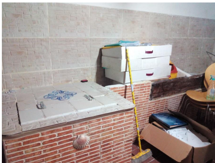
Il·lustració 23: Pou tapat amb dues lloses amb un abeurador a continuació i arreglat per fora. A l'interior s'hi distingien forats a la mateixa distància a dues bandes oposades del pou per a fer-los servir d'escala.
