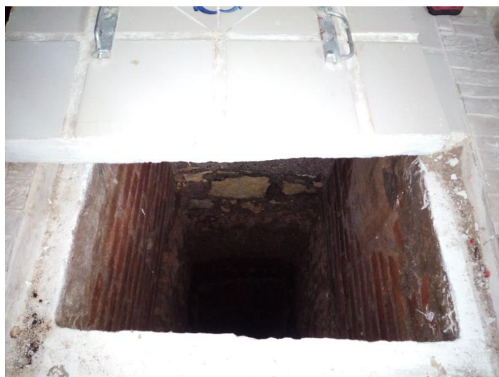
Il·lustració 24: Interior del pou. El primer graó es troba en l'espai d'un maó, com si faltés, però la coincidència també en l'altre costat i la presència de més forats de mateixa mida i gruix permeten deduir l'obra humana per a descendir al pou.
