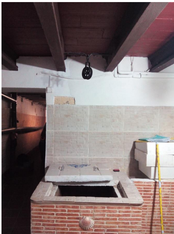
Il·lustració 25: Pou destapat d'una llosa amb la corriola encara al sostre.
