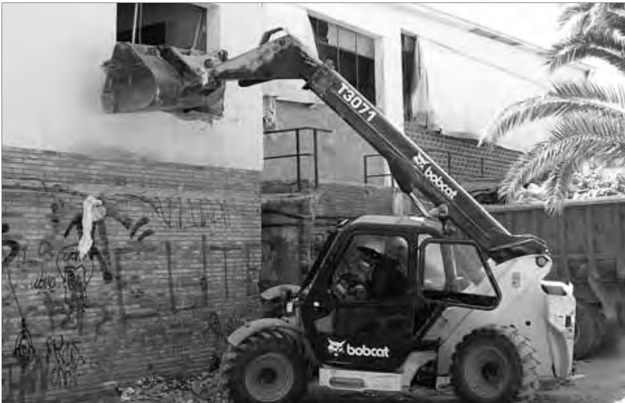
Una màquina, enderrocant les residències dels treballadors de l'antic hotel-balneari. [CEDIDA]
